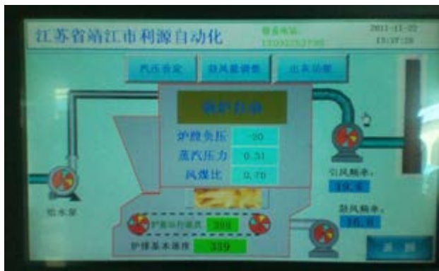
▲ 雪中飞公司安装锅炉风煤比变频节能系统
